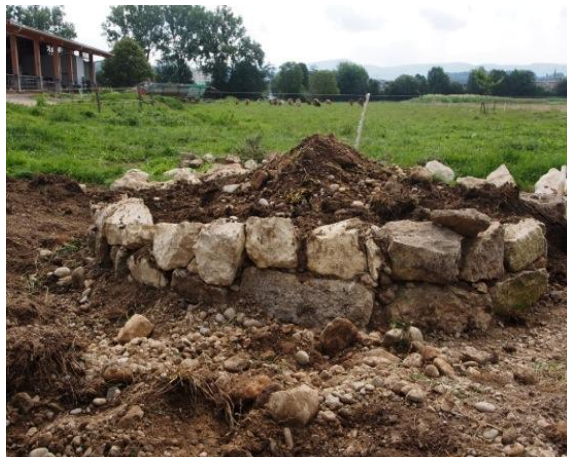
Abbildung 14 Trockenmauer und kegelförmiges Auffüllen mit Bauschutt und Erde
