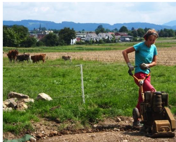
Abbildung 10 Befestigung der Bauschutts mit einer Vibroplatte
