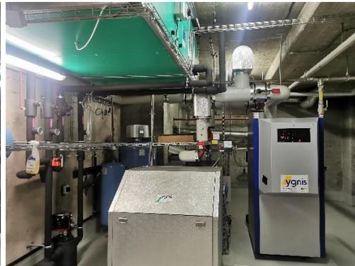
Abb. 30 Heizkessel der Öl- Gasheizung
